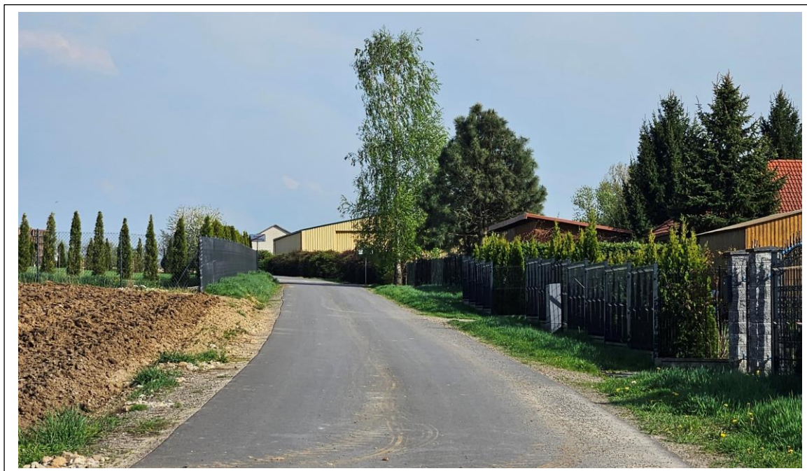
Fot. 7. Przebudowany ciąg drogowy w miejscowościach Palikije Pierwsze i Palikije Drugie (drogi wewnętrzne) na odcinku od km 0+002,84 do km 1+400,00.
