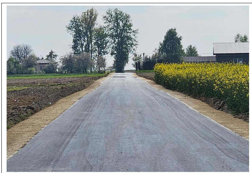
Fot. 13. Przebudowany odcinek drogi gminnej nr 196913L w miejscowości Romanówka o długości 892 m.
