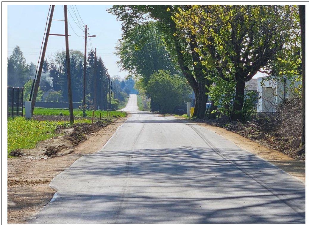
Fot. 12. Przebudowany odcinek drogi gminnej nr 196914L w miejscowości Ignaców o długości 714 m.
