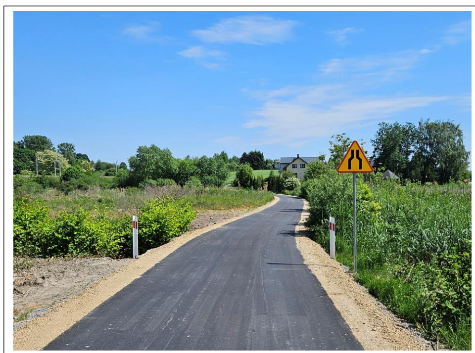
Fot. 8. Przebudowany ciąg drogowy dróg wewnętrznych w miejscowości Miłocin na odcinku od km 0+000,00 do km 0+839,25 oraz od km 0+000,00 do km 1+567,18.
