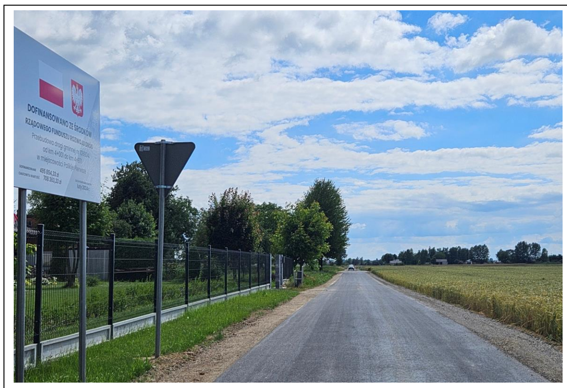
Fot. 6. Przebudowany odcinek drogi gminnej nr 106924L w miejscowości Palikije Pierwsze od km 4+001 do 4+871 (dz. nr ewid. 292) na długości 870 m.
