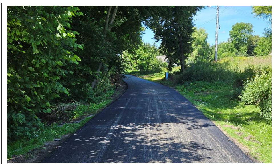
Fot. 30. Wyremontowana droga wewnętrzna (dz. nr ewid. 809) w Łubkach na odcinku 120 m.
