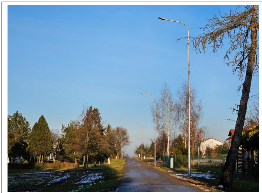
Fot. 28. Oświetlenie drogowe wybudowane w miejscowości Sporniak (Saganów) przy drodze wewnętrznej (dz. nr ewid. 629) i przy drodze gminnej nr 106927L.
