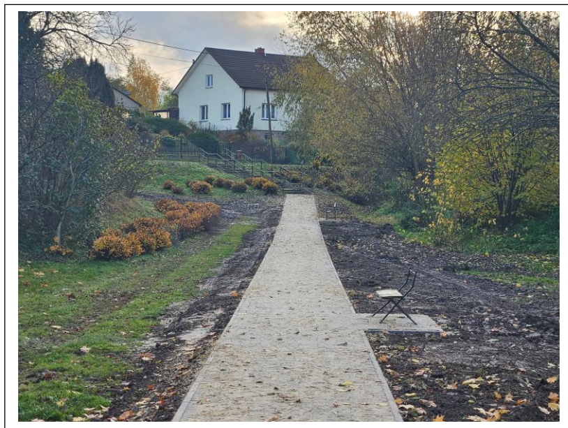
Fot. 32. Chodnik wybudowany w miejscowości Wojciechów.
