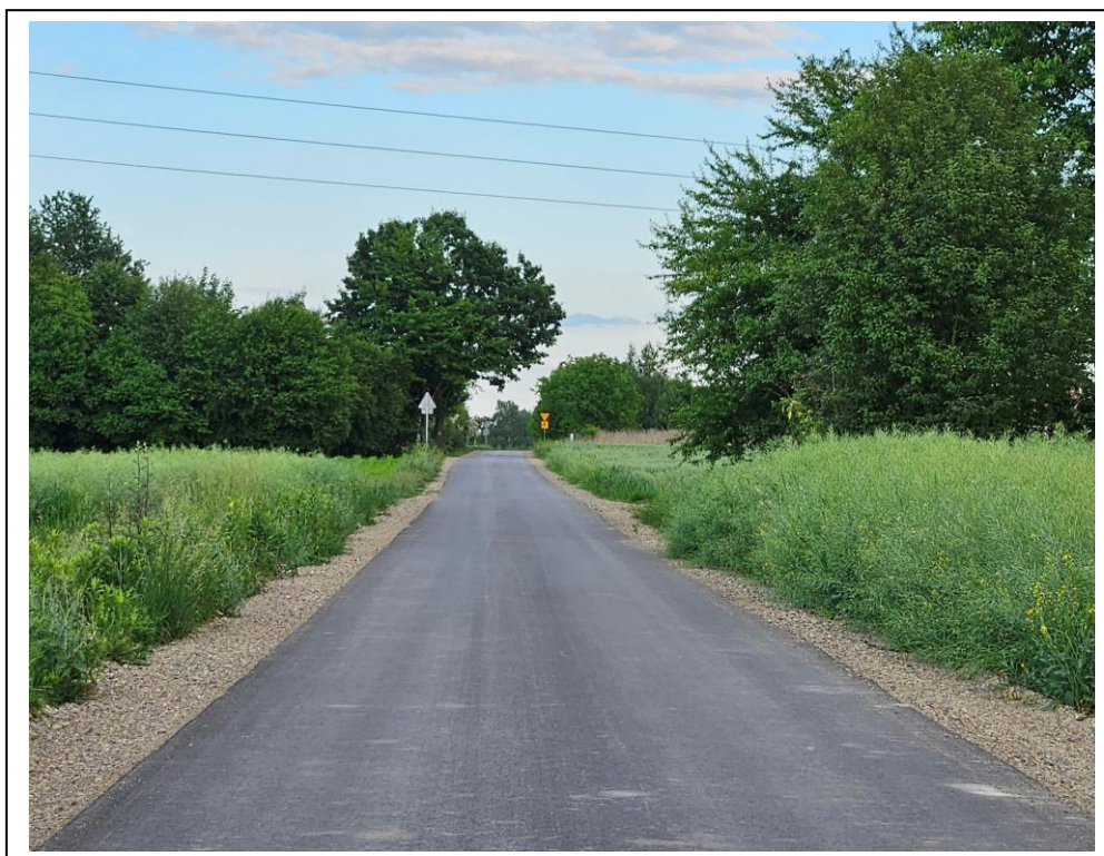
Fot. 5. Przebudowany odcinek drogi gminnej nr 106915L w miejscowości Ignaców od km 2+141,95 do 2+783,30 (dz. nr ewid. 292) na długości 640 m.
