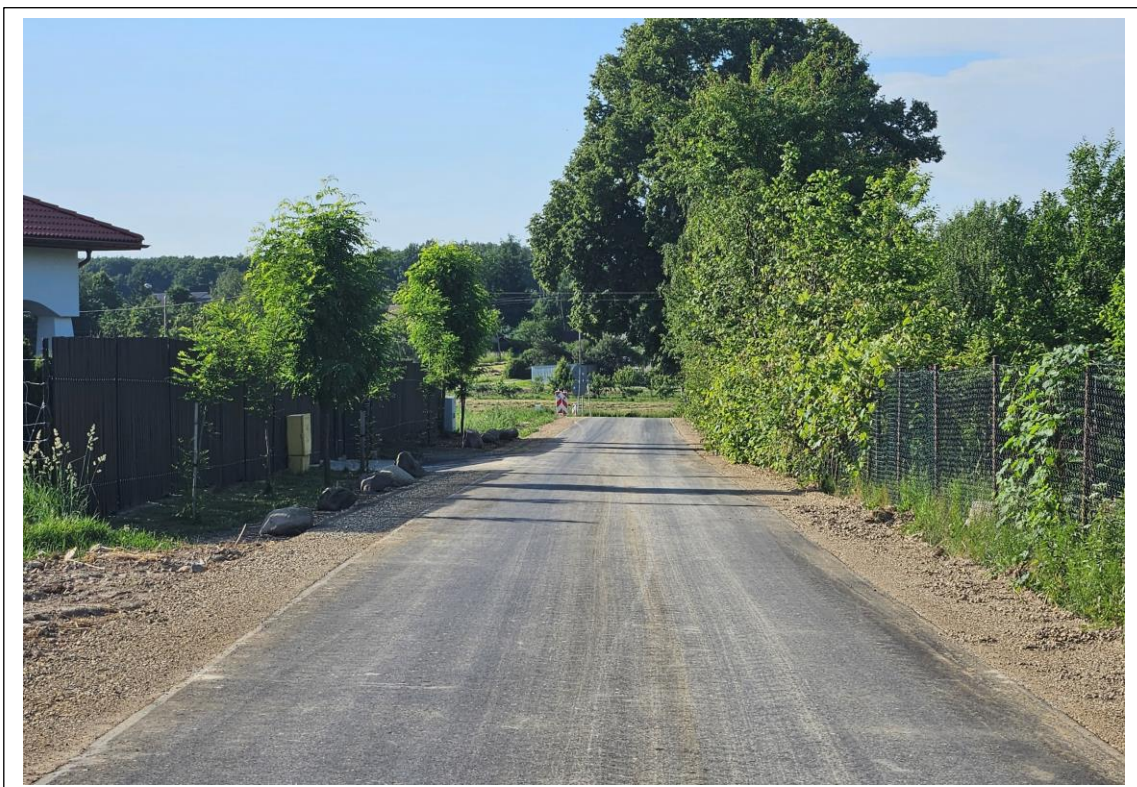
Fot. 9. Przebudowany odcinek drogi wewnętrznej w miejscowości Sporniak o długości 758 m (dz. nr ewid. 636).
