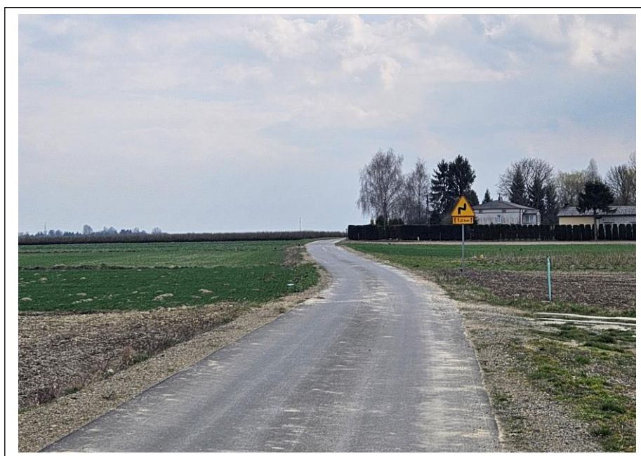
Fot. 15. Przebudowany odcinek drogi gminnej nr 106907L w miejscowości Halinówka o długości 240 m.
