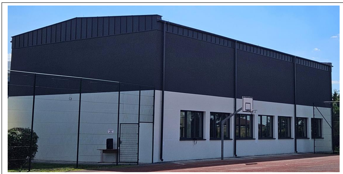
Fot. 16. Wybudowana sala gimnastyczna z zapleczem przy Szkole Podstawowej im. Józefa Gadeckiego w Palikijach.
