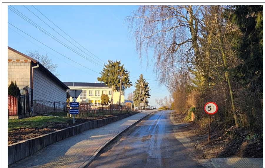
Fot. 29. Przebudowana droga gminna nr 106925L w zakresie budowy drogi dla pieszych w miejscowości Palikije Pierwsze na odcinku 130 m.
