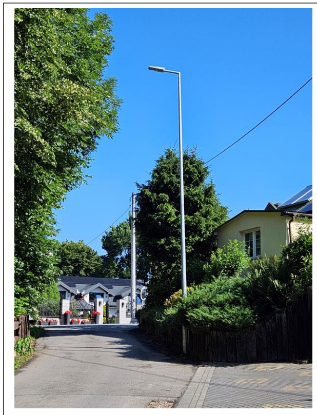
Fot. 23. Wybudowane oświetlenie w miejscowości Wojciechów (Plizin).
