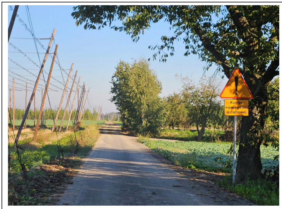
Fot. 22. Przebudowana droga wewnętrzna w miejscowości Szczuczki na odcinku 502 m (dz. nr ewid. 254).
