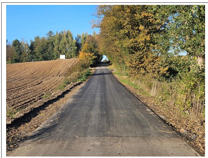
Fot. 31. Wyremontowana droga gminna nr 106917L w miejscowości Maszki.
