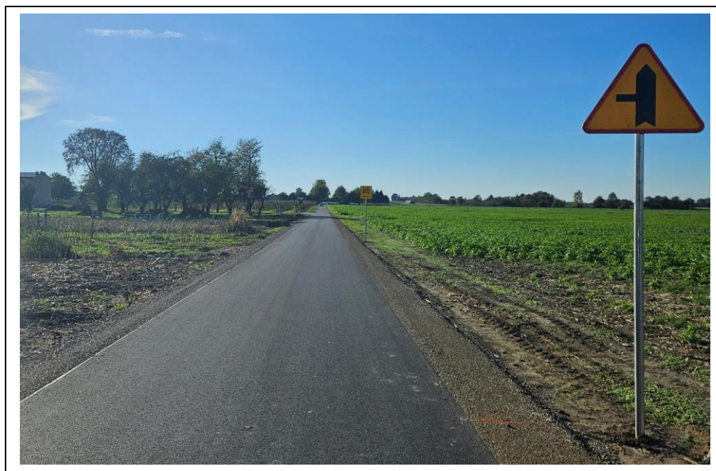
Fot. 21. „Przebudowa dróg gminnych na obszarze po PGRowskiem” – przebudowana została droga gminna nr 106928L w miejscowości Palikije Drugie na odcinku 850 m.
