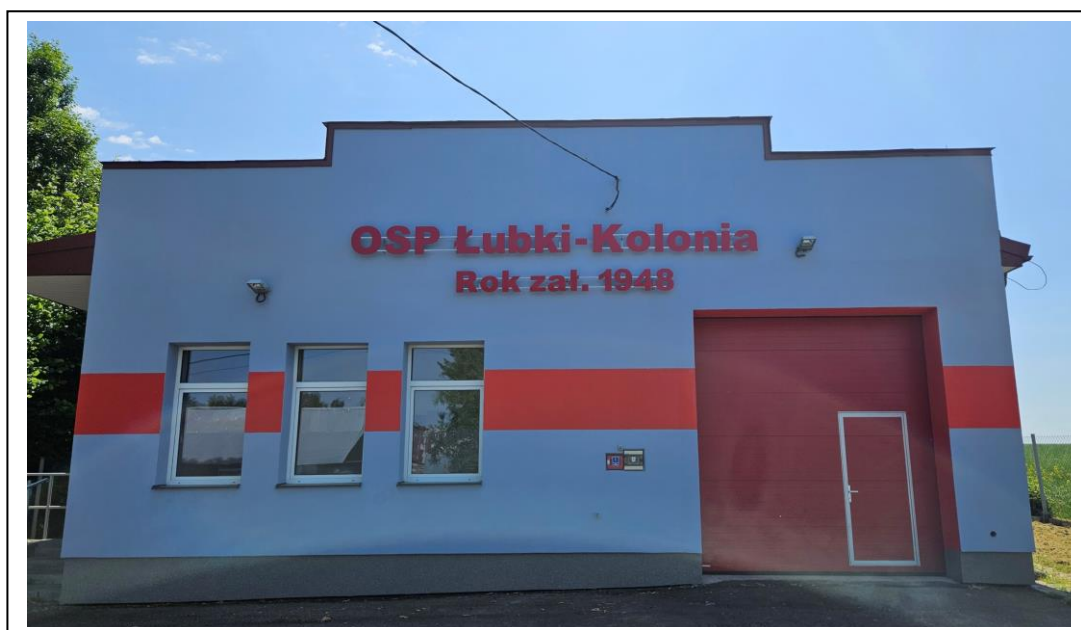
Fot. 69. Remiza OSP Łubki Kolonia.
