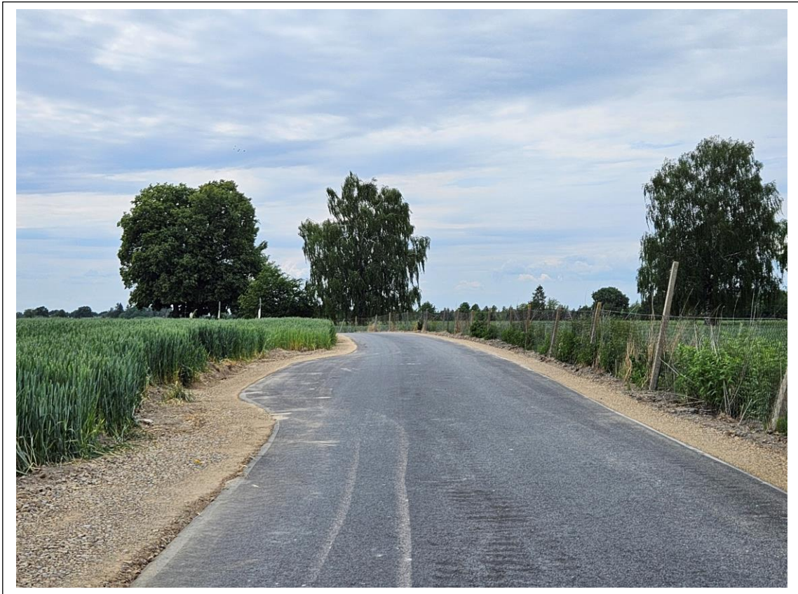
Fot. 10. Przebudowany odcinek drogi wewnętrznej w miejscowości Stasin o długości 686 m (dz. nr ewid. 152).
