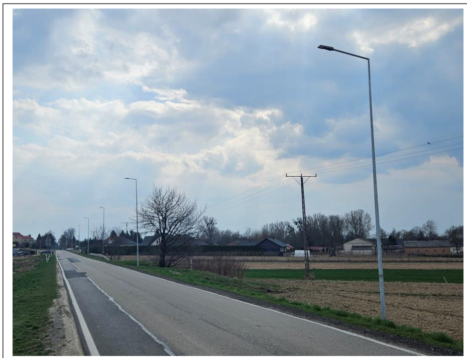
Fot. 24. Wybudowane oświetlenie w miejscowości Wojciechów (wzdłuż drogi wojewódzkiej 827).
