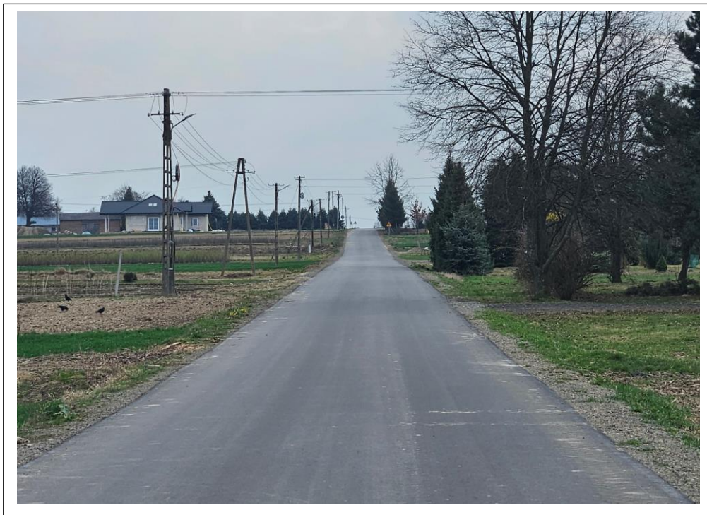
Fot. 14. Przebudowany odcinek drogi gminnej nr 106909L w miejscowości Cyganówka o długości 969 m.
